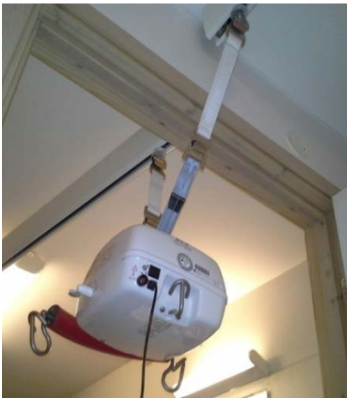
Detalj av overkroking mellom to skinner
