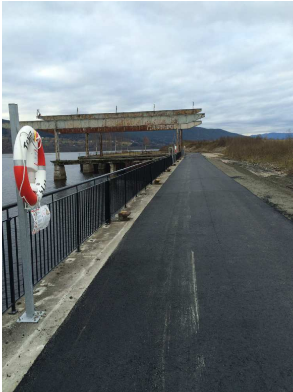
Figur 3 Etter: Asfaltering i oktober 2015
